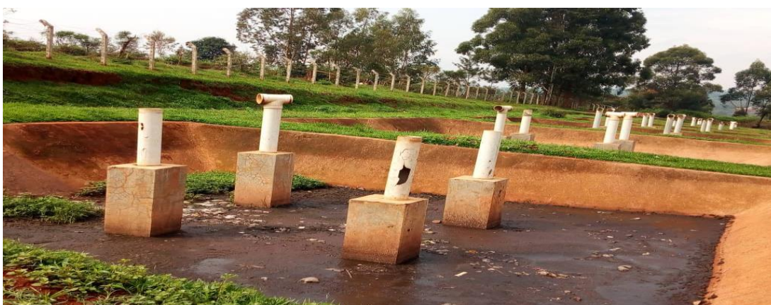
Figure 8: Site de dépotage des boues de vidange de NTOBWE à GITEGA
