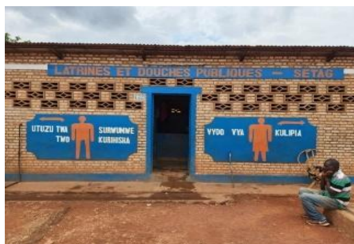
Figure 12: Toilettés Publiques situées à Gitega
